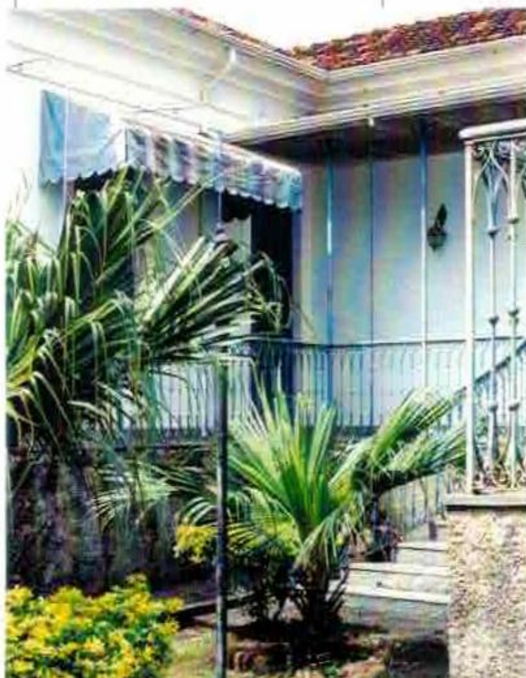
Detalhe do gradil e varanda
