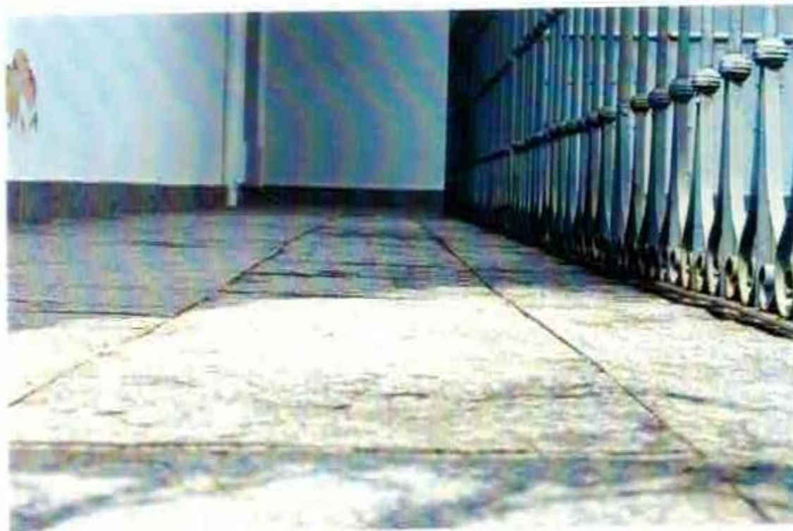
Detalhe do piso da varanda
