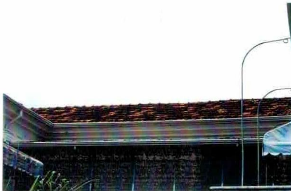
Vista da platibanda
